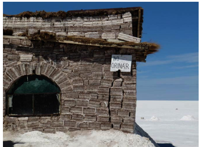
Das passiert, wenn man immer die selbe Ecke benützt (ehem. Salzhotel, gebaut mit Salzquader)
